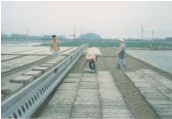
圖 8.9 育苗中心之高架搬運系統
